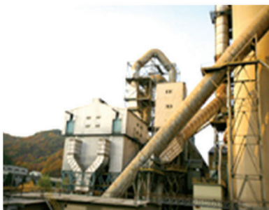
Lắp Đặt Mới Lọc Bụi
