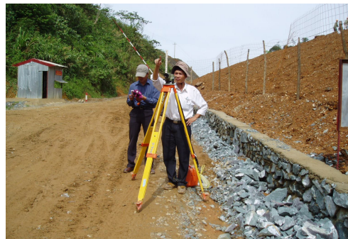
Hình 6b. Đo dẫn độ cao nối hai cửa hầm
