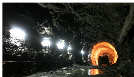
Hình 4. Thi công đường hầm bằng phương pháp khoan nổ
