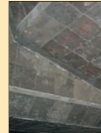
Lớp lót trần hoàn toàn đúc sẵn
