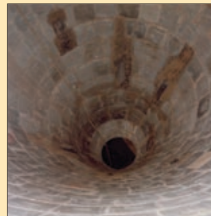
Lớp lót đúc sẵn hình nón và hình trụ. Lắp đặt rất nhanh. Không cần hệ neo.
