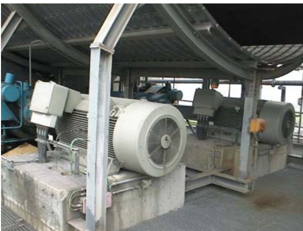
Hình 7 .Lắp biến tần cho các động cơ
